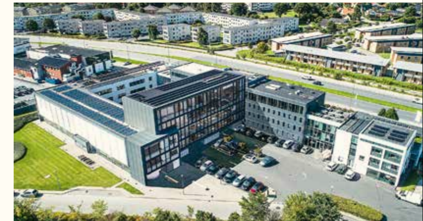
OK's hovedkontor har siden 1980 ligget ud til Viby Ringvej. Gennem årene har man udvidet otte gange – senest med en tilbygning på fem etager, der blandt andet skal rumme nye mødelokaler og en større og mere moderne kantine.
